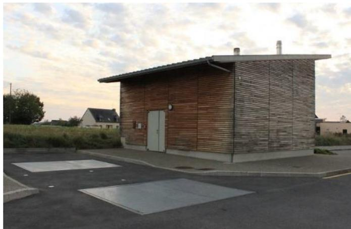
La chaufferie bois est une structure qui s'intègre généralement bien architecturalement dans l'environnement proche si l'on se place dans le contexte d'un projet urbain de ce type. Elle nécessite cependant une attention particulière sur l'aménagement des voiries afin de permettre une desserte optimisée par poids lourds.
