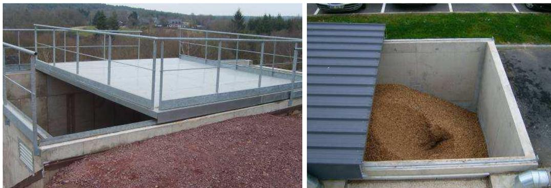
Le silo est en général dimensionné suivant l'autonomie à pleine charge de la chaudière souhaitée (généralement de 3 à 5 jours).
